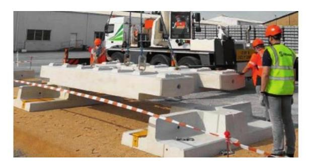
Французские компании SYSTRA и STRADAL (специализируется на конструкциях из сборного железобетона) показали на выставке разработанную совместно новую конструкцию безбалластного пути, которая пригодна для линий всех типов — от высокоскоростных и пригородных до грузовых.
