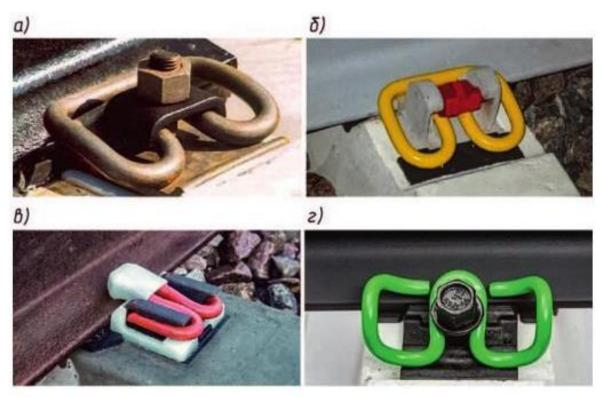
Образцы современных скреплений: a - ЖБР-65; 6 - APC-4; B - Pandrol-350;  $\Gamma - \text{Vossloh W30}$
