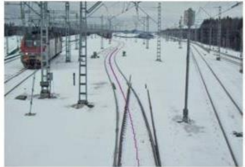
Рис. 2. Железнодорожная колея, покрытая снегом.
