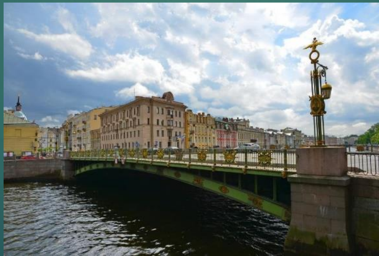
Пантелеймоновский мост, Санкт-Петербург
