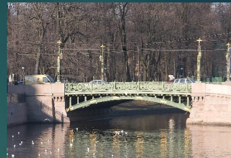
1-й Садовый мост, Санкт- Петербург
