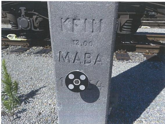
*Рис. 3. Маркеры контрольных точек, расположенные на опорах контактной сети*
