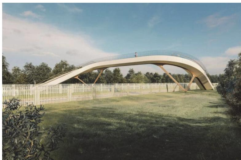
На выставке Rail Live, прошедшей 16-17 июня 2021 года в испытательном центре UKRPIN<sup>1</sup> в местечке Лонг-Марстоне, графство Уорикшир, оператором железнодорожной инфраструктуры Великобритании Network Rail был представлен опытный образец конструкции экологически чистого модульного пешеходного моста FLOW через железнную дорогу.
