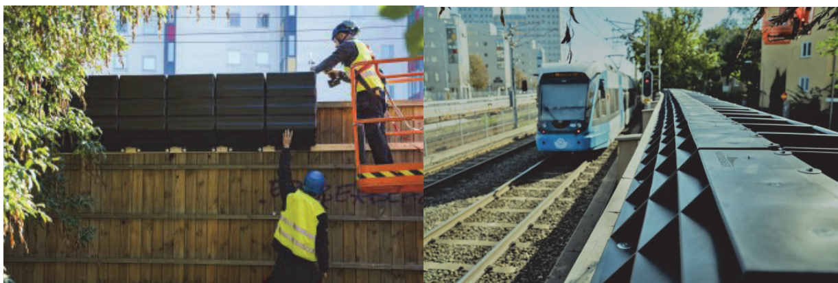
Рис. 1. Установка шумозащитного модуля
