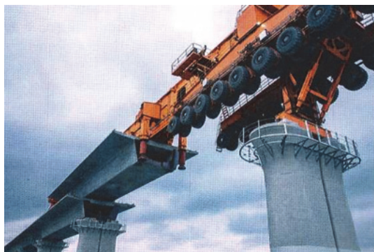
Рис. 1. Начало укладки 500-метрового двойного стального пути на бетонные опоры
