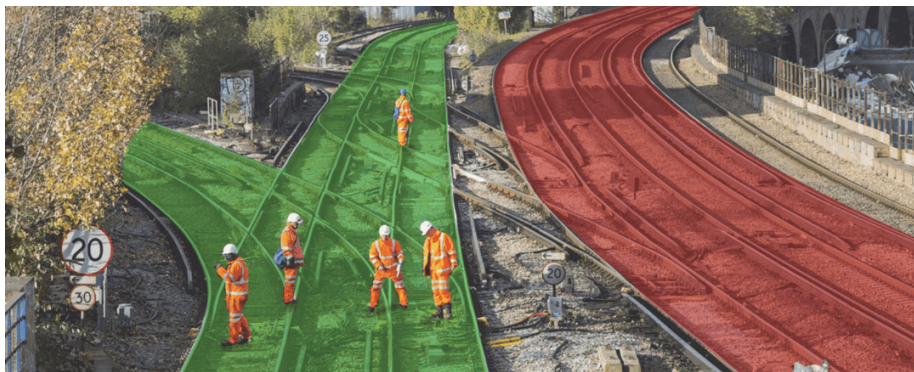
Рис 1. Виртуальные границы опасных (красный цвет) или безопасных зон (зеленый цвет) на железнодорожных путях
