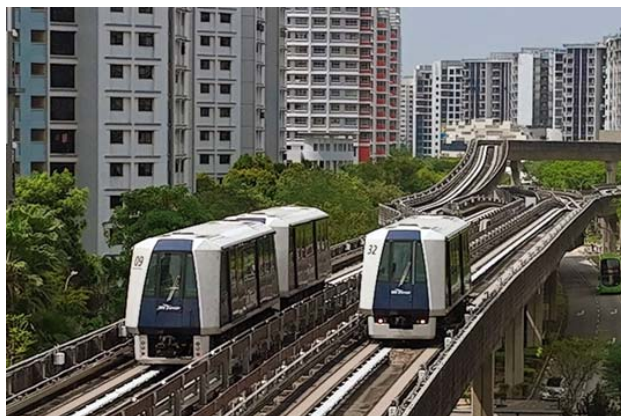
Рис. 9. Транспортная система Sengkang-Punggol LRT
