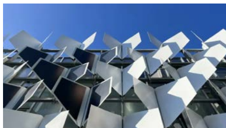
Рис. 32. Новый адаптивный фасад FlectoLine
