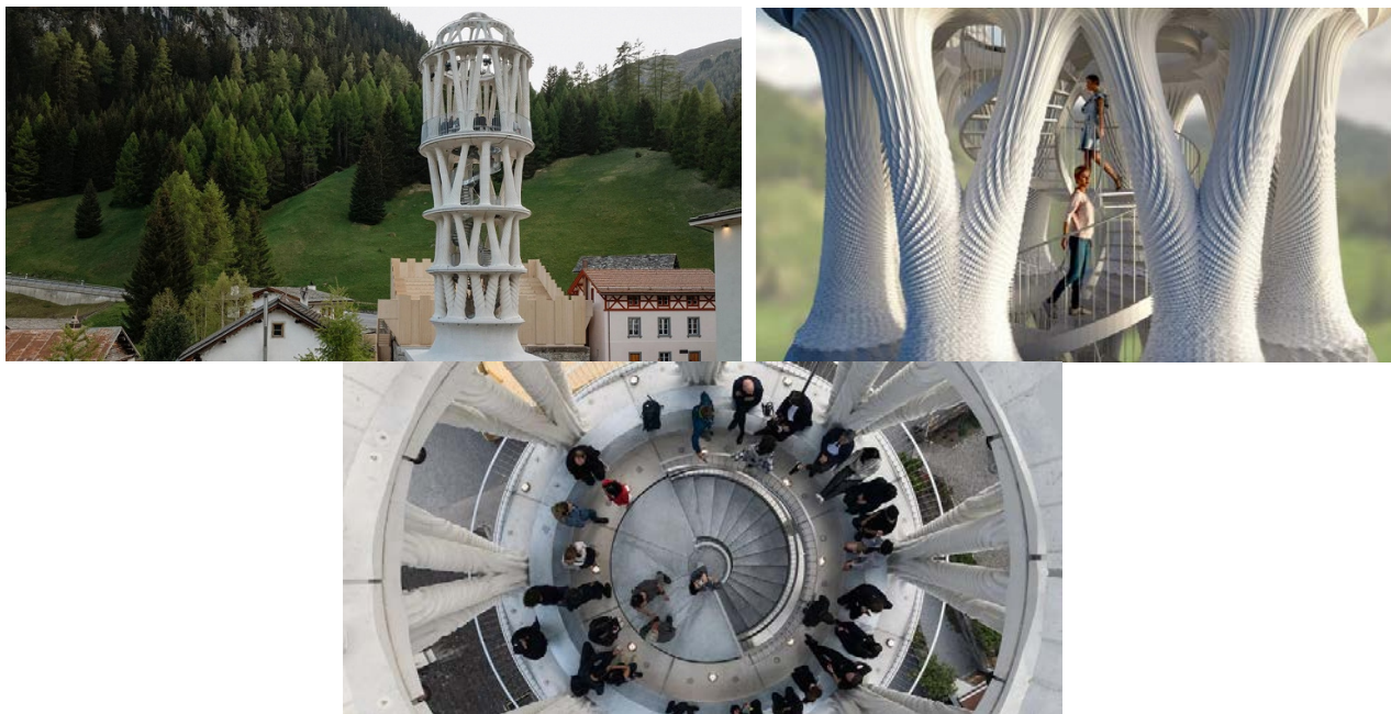
Рис. 19. Самое высокое в мире здание, напечатанное на 3D-принтере
