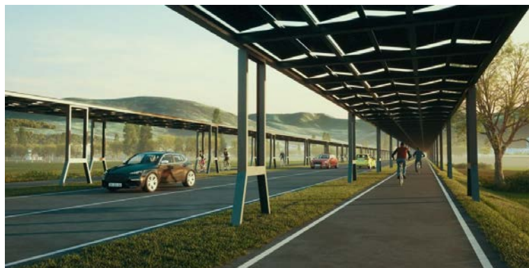
Рис. 20. Система для автономного энергоснабжения велосипедных дорожек
