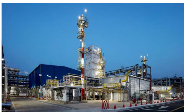
Рис. 20. Крупнейший в мире завод по производству жидкого водорода в Инчхоне, способный производить 30 тысяч тонн жидкого водорода в год, начал работу 8 мая
