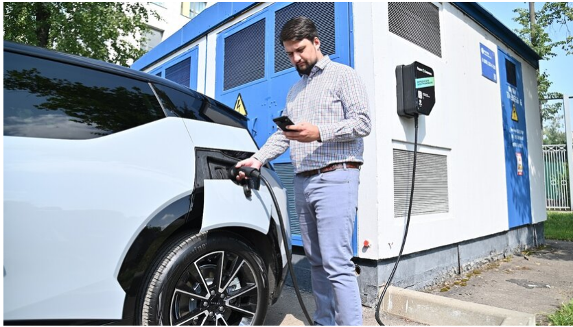
Рис. 20. Новая зарядная станция для электрокаров
