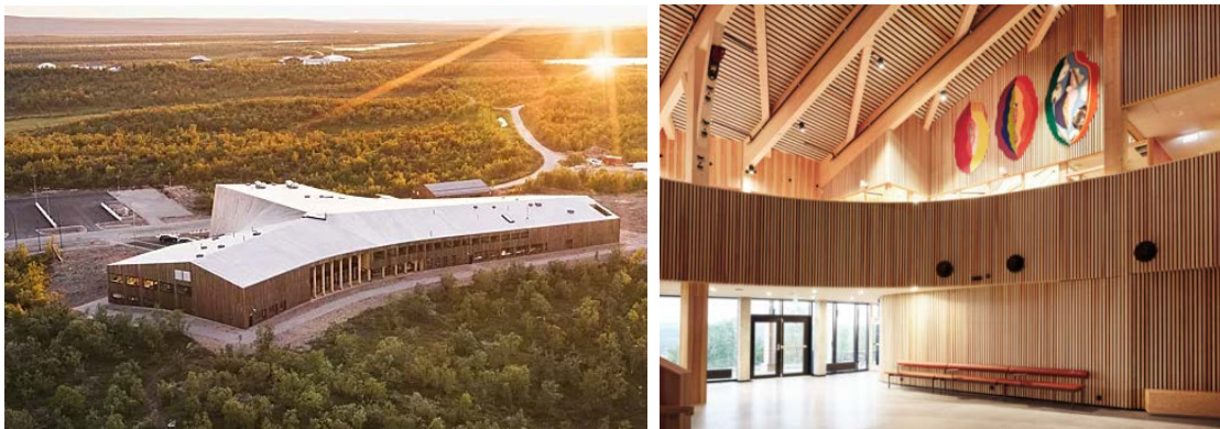
Рис. 16. Здание, которое практически не нуждается в отоплении даже при -45^{\circ}\text{C} .
