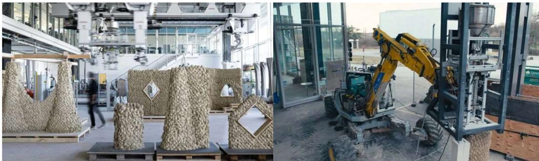
Рис. 15. Новый вариант строительного принтера
