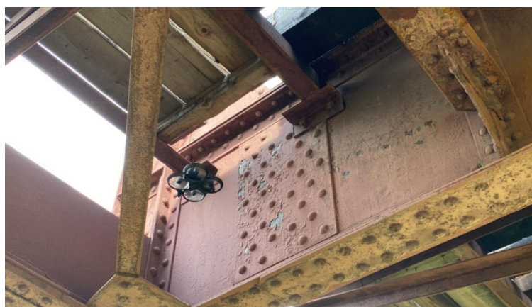
Рис. 3 Осмотр моста с помощью FPV-дрона
