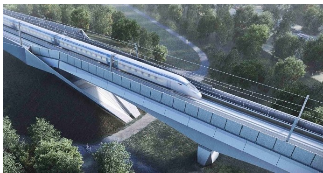
Рис. 1. Строящийся виадук для High Speed
