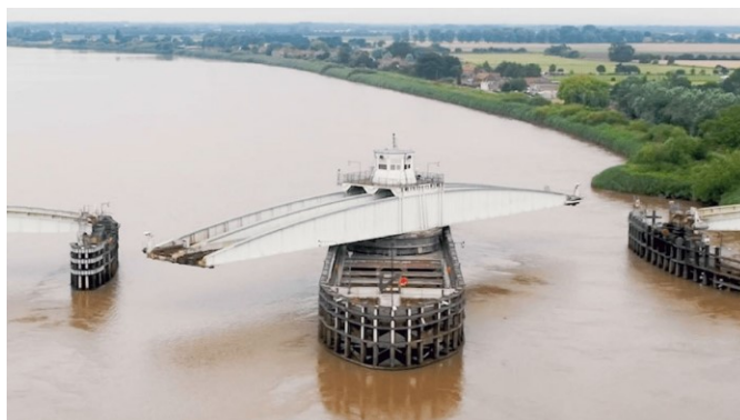
Рис. 1. Моста Скелтон с поворотным пролетом через реку Уз
