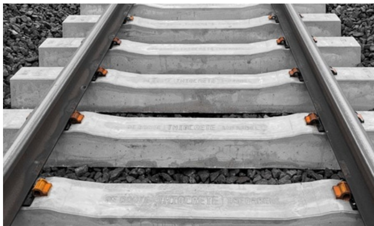
Рис. 9. Шпалы компании THIOTRACK из серобетона
