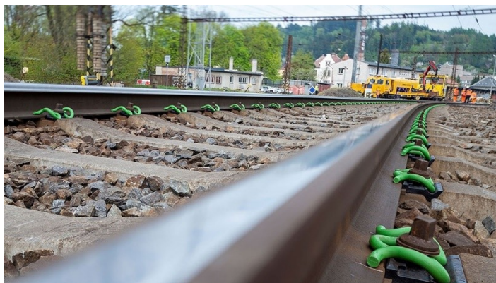
Рис. 3. Системы рельсовых креплений для ВСМ
