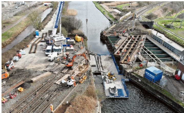
Рис. 1. Реконструкция единственного в Великобритании железнодорожного моста с поворотным пролетным строением
