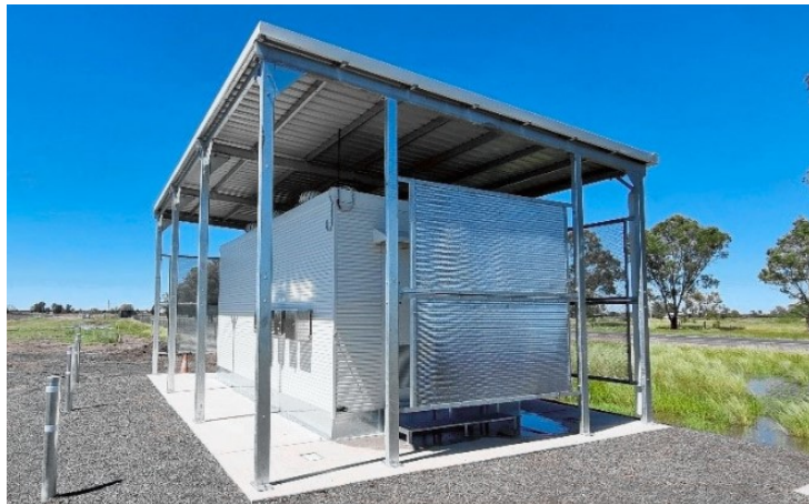
Рис. 2. Аппаратный контейнер с пассивным охлаждением
