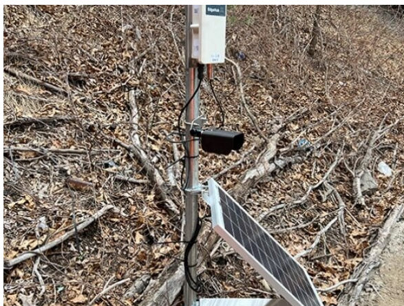
Рис. 3. Интеллектуальное решение Keolis для беспроводного мониторинга после повреждения путей MBTA в результате наводнения
