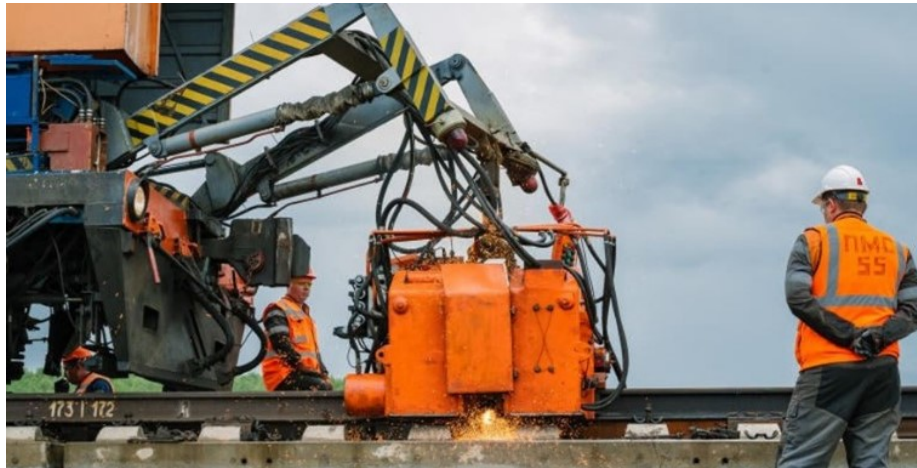
Рис. 1. Опытная сварка рельсов для ВСМ
