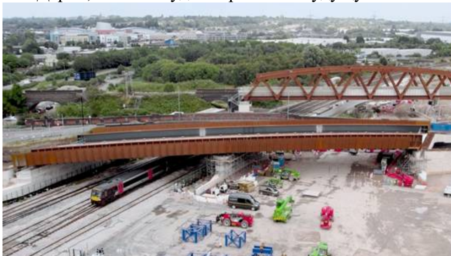
Рис. 4. Надвиг пролетного строения моста Астон-Черч
