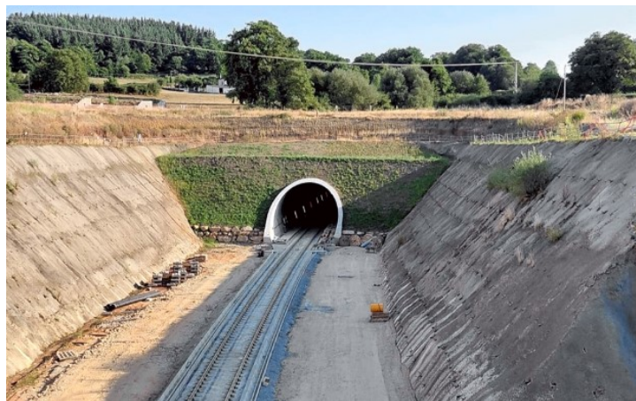
Рис. 6. Однопутный тоннель Оураль
