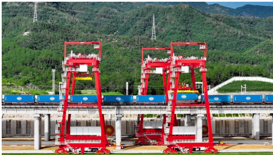
Рис. 1. Контейнерный терминал Суси
