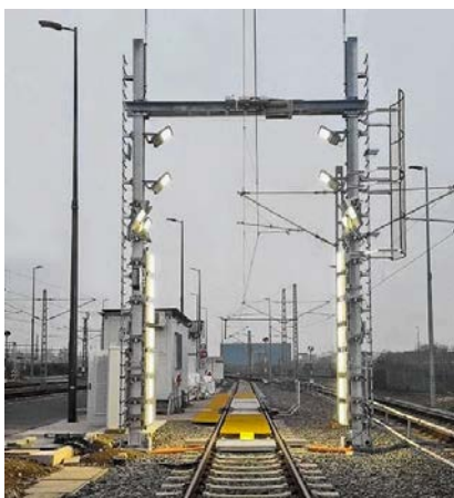
Рис. 1. Диагностический портал осмотра высокоскоростных поездов ICE
