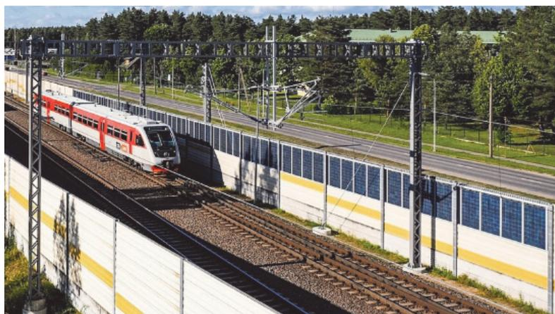
*Рис. 11. Шумозащитные барьеры со встроенными солнечными панелями*
