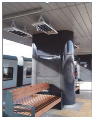
Рис. 7. Скамейки с инфракрасными обогревателями на ж/д станции Зеленоград-Крюково в Москве
