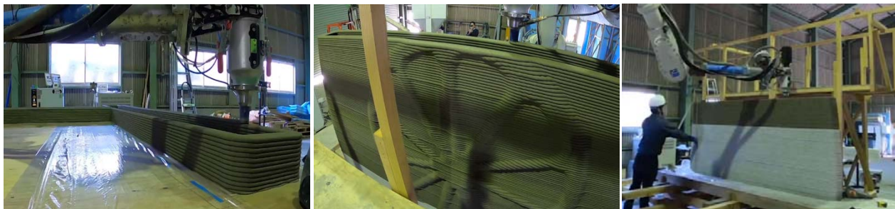
Рис. 1. Процесс 3D печати здания
