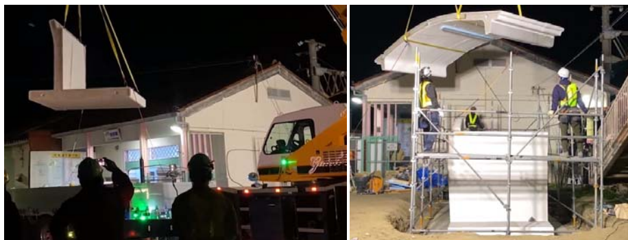
Рис. 2. Сборка здания по частям
