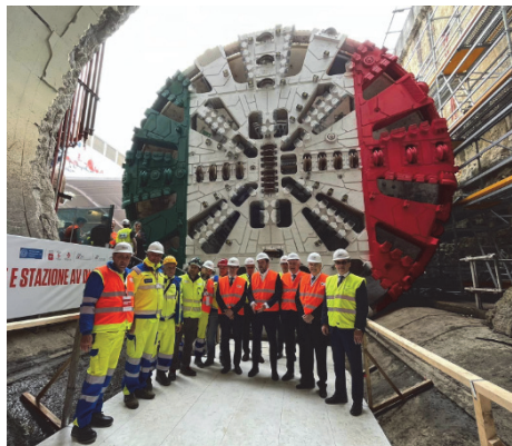
Рис. 1. Строители и туннелепроходческая машина EPB TBM
