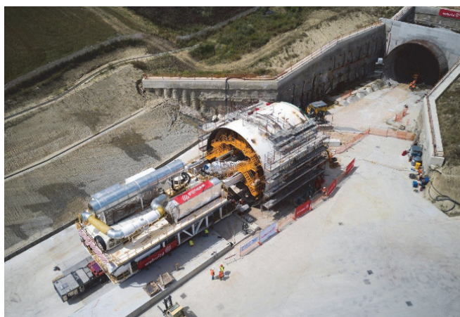
Рис. 5. Туннелепроходческая машина Aurora
