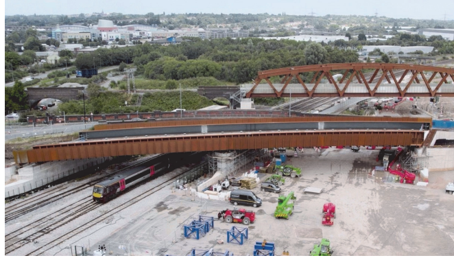
Рис. 2. Надвиг пролетного строения моста Астон-Чёрч
