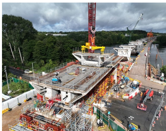
Рис. 3. Строительство виадука HS2
