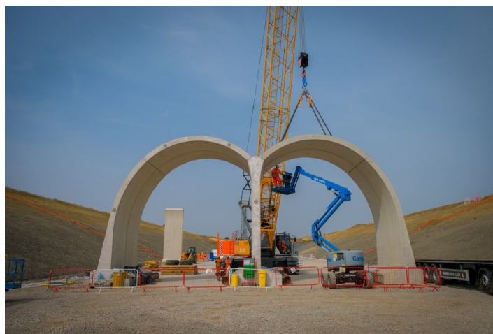
Рис. 2. Инженеры за работой над первой аркой для «зеленого» тоннеля Грейтворт
