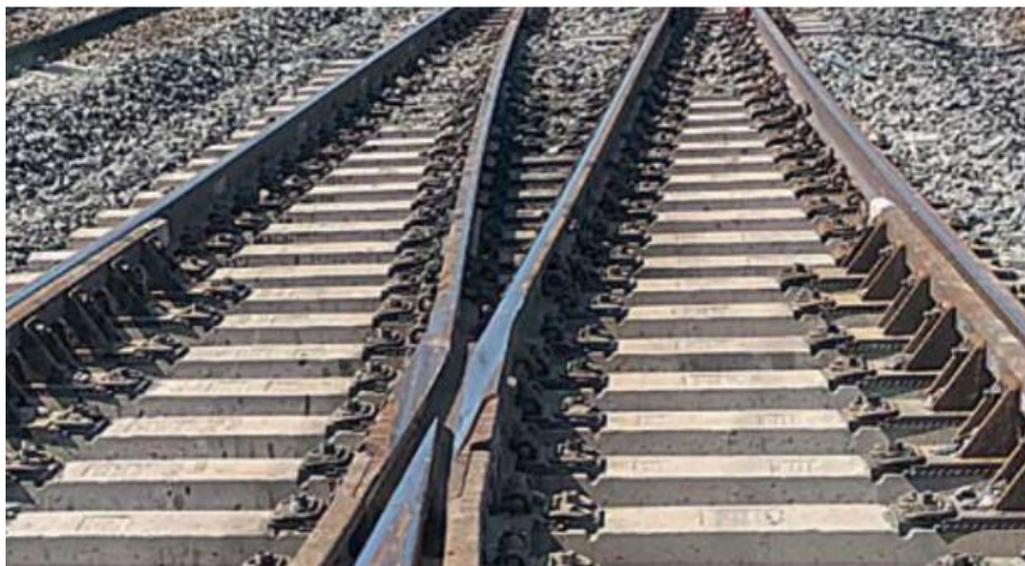
Потребность ОАО «РЖД» в стрелочных переводах для участков пути с высокой интенсивностью движения и повышенными нагрузками на ось подвижного состава обеспечивается новыми стрелочными переводами типа
