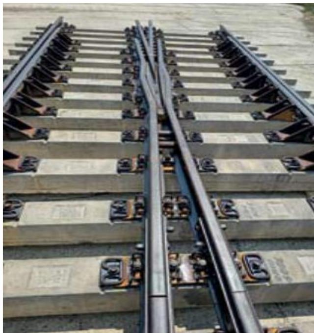
Стрелка оборудована комплектом гарнитуры электропривода типа СП-6М без внешнего замыкателя, располагающейся в полых металлических брусках, что позволяет:
