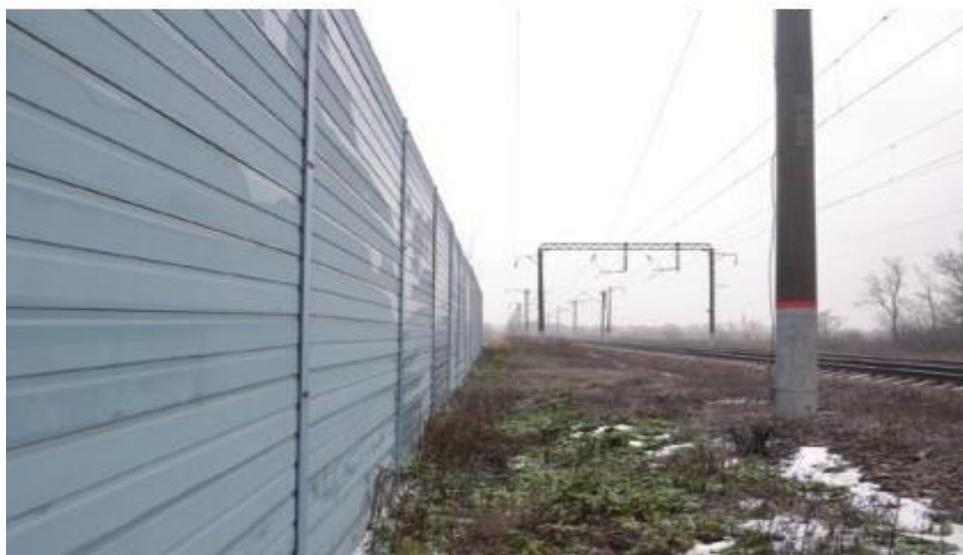
Сравнительный расчет стоимости жизненного цикла 1 м(2) экрана из оцинкованной стали и экрана из ПКМ, учитывающий затраты на строительство, промежуточные ремонты и эксплуатацию в течение 50 лет, показал, что у экрана из стали эта стоимость почти в 2 раза выше, чем у экрана из ПКМ.
