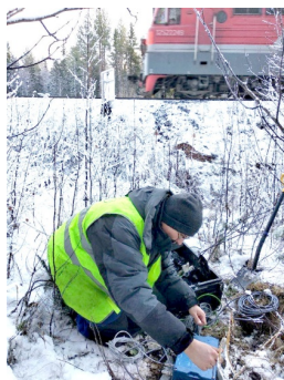
Рис. 1. Установка оборудования у основания насыпи железнодорожного полотна
