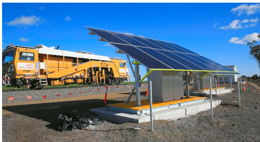
Рис. 2 Солнечные панели для питания аппаратуры ЖАТ
