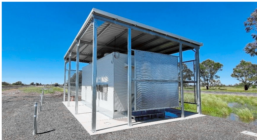
Рис. 1 Аппаратный контейнер с пассивным охлаждением
