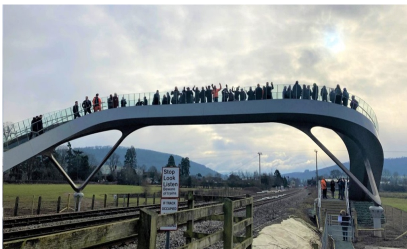
Рис.2 Мост Flow В Шпрошиуре
