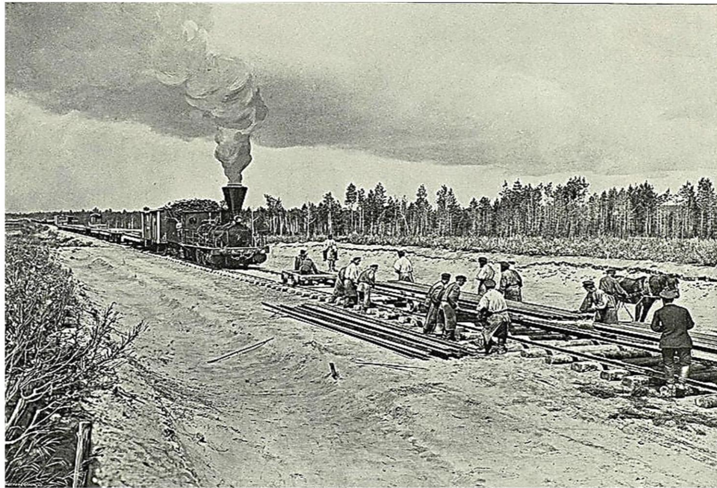
Укладка пути. Альбом «Великий путь. Виды Сибири и Великой сибирской железной дороги» 1899
