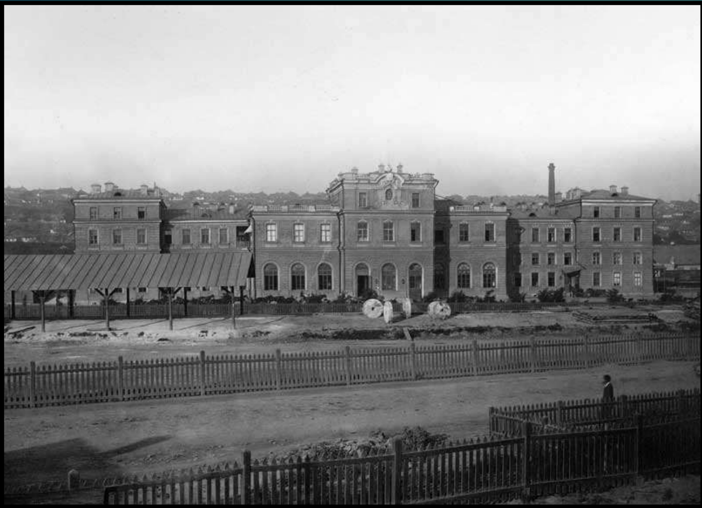
Вокзал на стадии строительства
