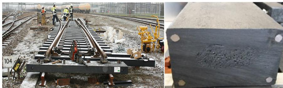
*Рис. 2. Гибридные полимерные шпалы для стрелочных переводов и переходов*
