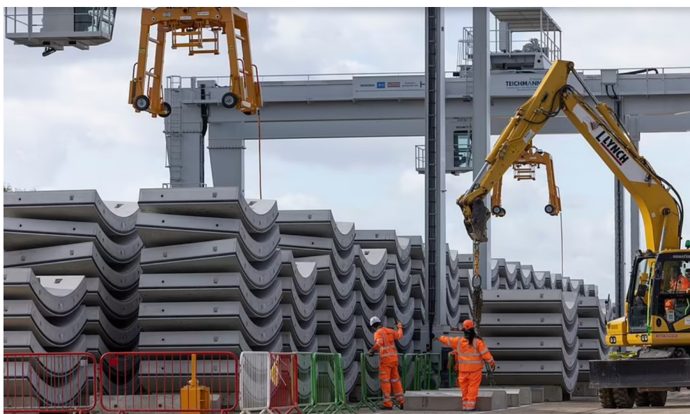
Рис.2. Сегменты тоннелей высокоскоростной железнодорожной магистрали HS2
