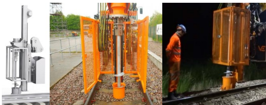
Рис. 2. Оборудование для установки микросвай
