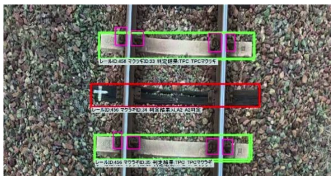
Рис. 2. Система оценки способна выявлять неисправности компонентов, в том числе степень износа деревянных шпал
