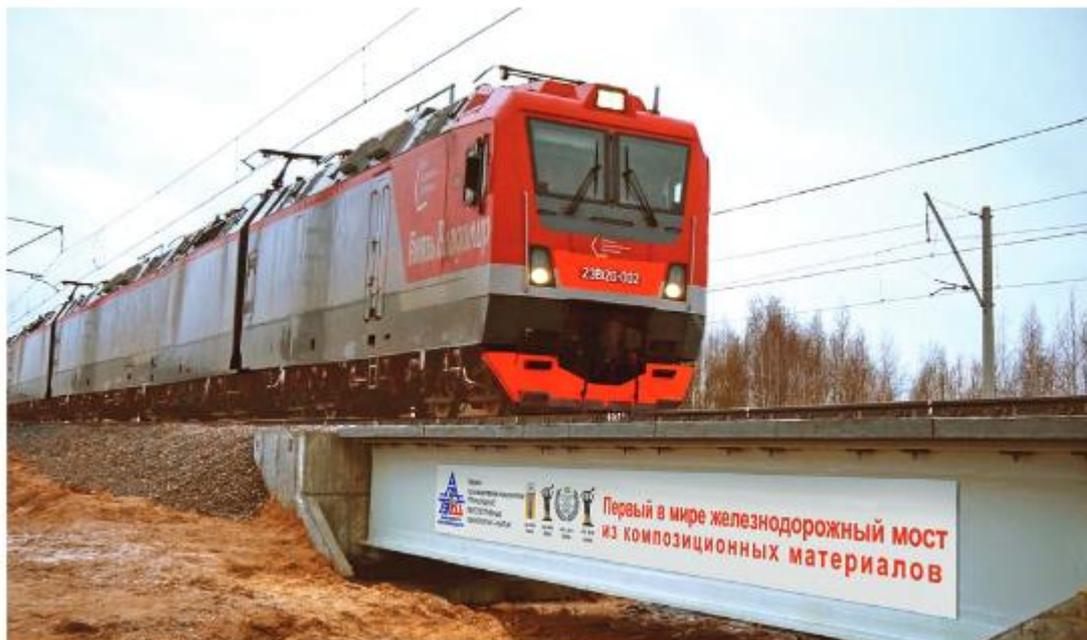
Эксплуатационные испытания ПС КМ на Экспериментальном кольце ВНИИЖТ.
