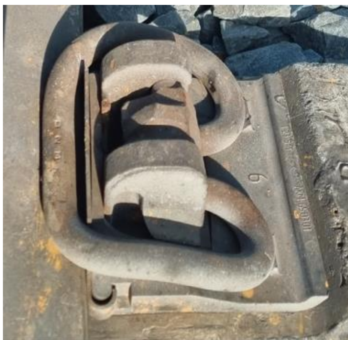
Скрепление АКМ-65 на опытном участке
