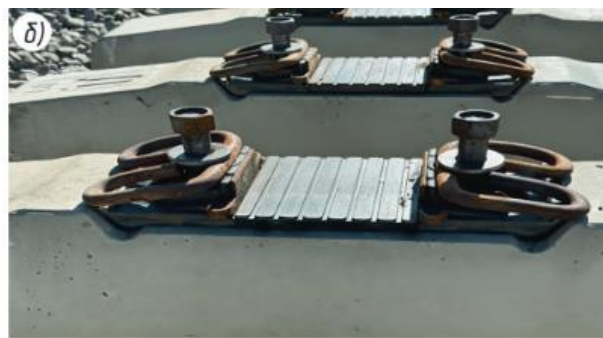
Общий вид шпал из серобетона до монтажа креплений (а) и после установки креплений ЖБР-65ППР (б)
