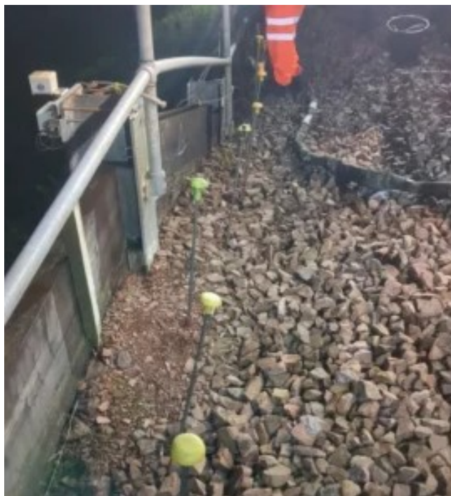
Рис. 1. Балласт с инжекционными трубками
